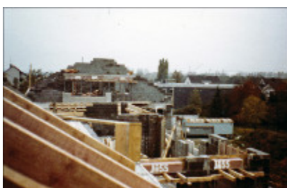
Neubau der Ladenzeile Paul-Langen-Str. 44
