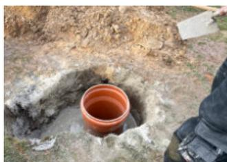
Abstandsregeln wurde ein großes Loch gegraben, in welches am nächsten Tag die Bodenhülle für den Baum einbetoniert wurde.
