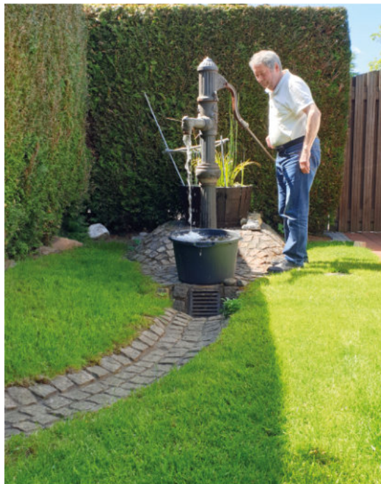
Mit der Schwengelpumpe wird das Regenwasser aus 5 m Tiefe gefördert
