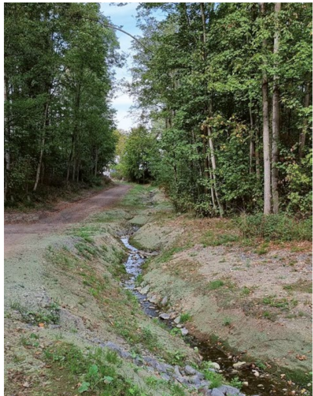
Bachlauf unterhalb des Hochwasserrückhaltebeckens © Stadt Bonn Tiefbauamt
