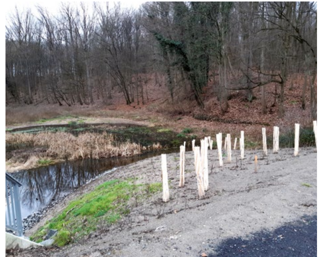
Restwassermenge im Hochwasserrückhaltebecken © Stadt Bonn Tiefbauamt
