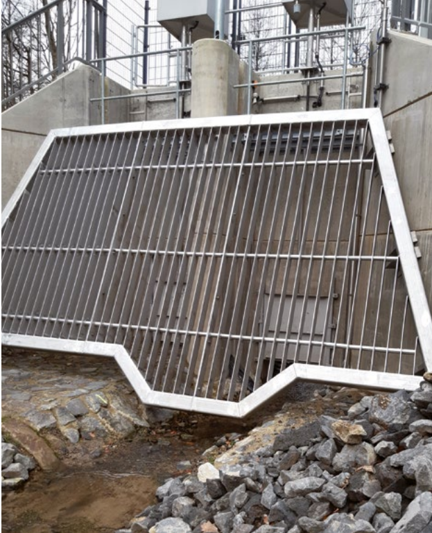
Neues Durchlass- und Drosselbauwerk © Stadt Bonn Tiefbauamt
