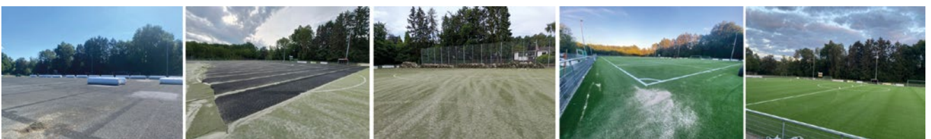
Die einzelnen Bauphasen der Sanierung des Spielfeldes © Christoph Rauscher
